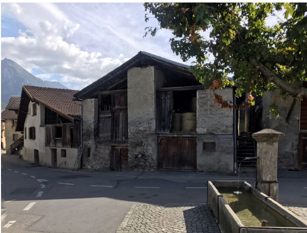
Leer stehender Ökonomiebau an der Dorfstrasse
