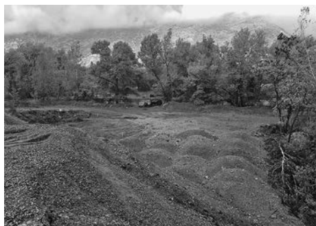
Auffüllarbeiten durch die Bauunternehmung
